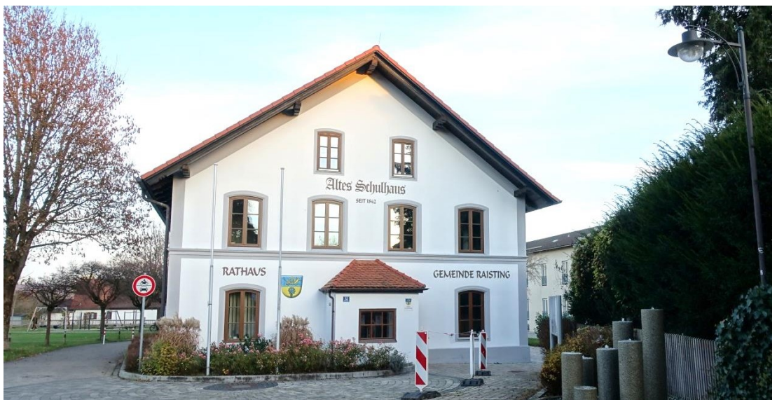
Abb. 22 Zum Kirchenweg grenzständiges Rathaus (ehem. Schulhaus), Quelle: PV München, Stand 15.11.2020
