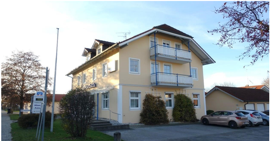
Abb. 23 Raiffeisenbank an der Pähler Straße mit Walm (Fl.nr. 712/1), Quelle: PV München
